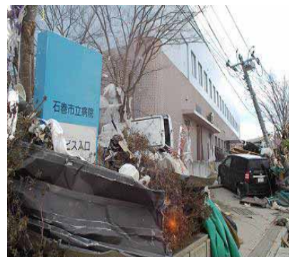
大きな被害を受けた石巻市立病院。地震後、約150人の入院患者が救出された（石巻市内）
